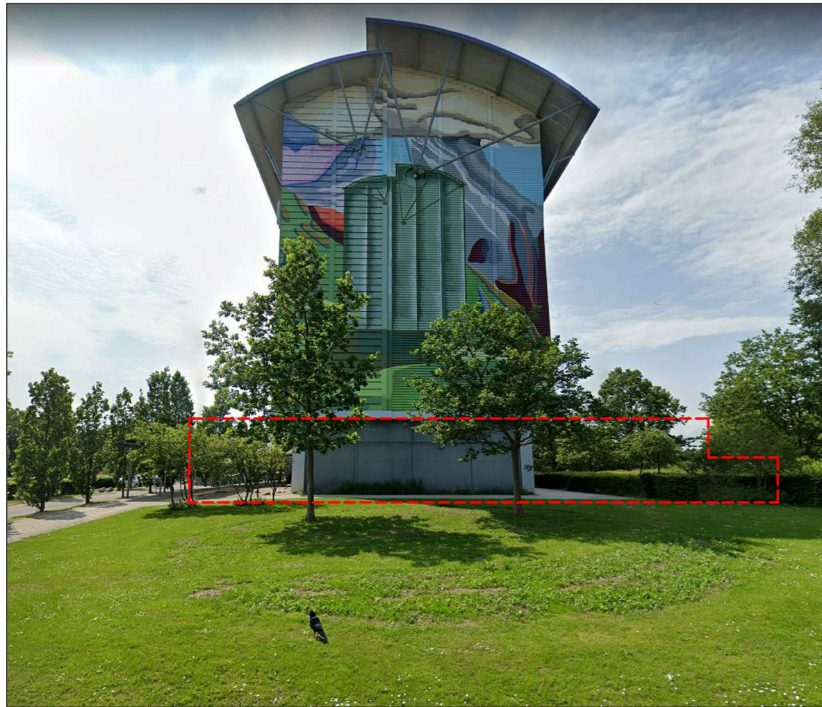
View fra Heimdalsvej
