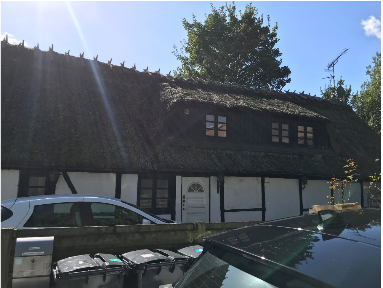
Facade mod nord, gårdsplads
