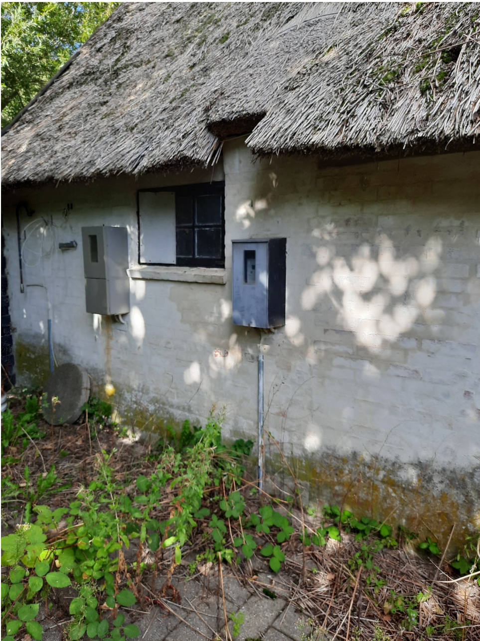
På facaden der peger væk fra gårdspladsen er der ikke noget af det originale bindingsværk tilbage.
