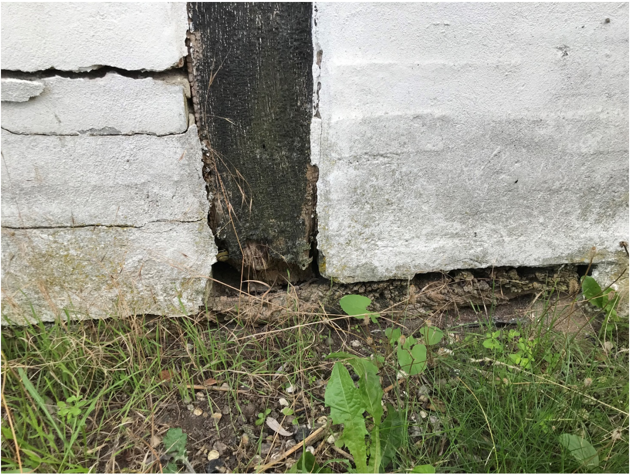
Terrænet er hævet, så bundrem er forsvundet. Revner i tavler. Råd i bindingsværk.
