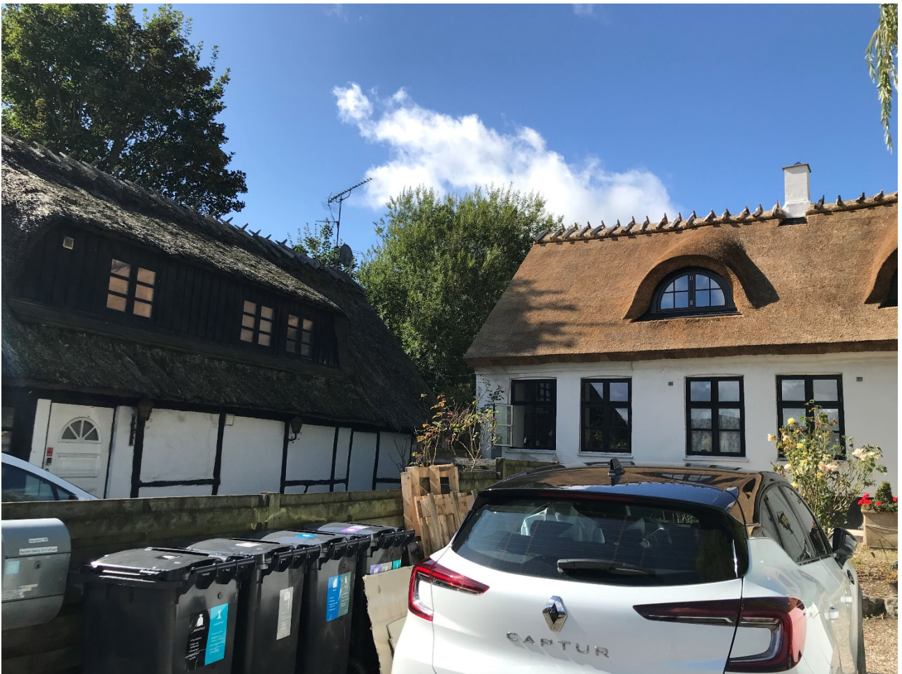
Terrænet er hævet, så bundrem er forsvundet. Revner i tavler. Råd i bindingsværk.
