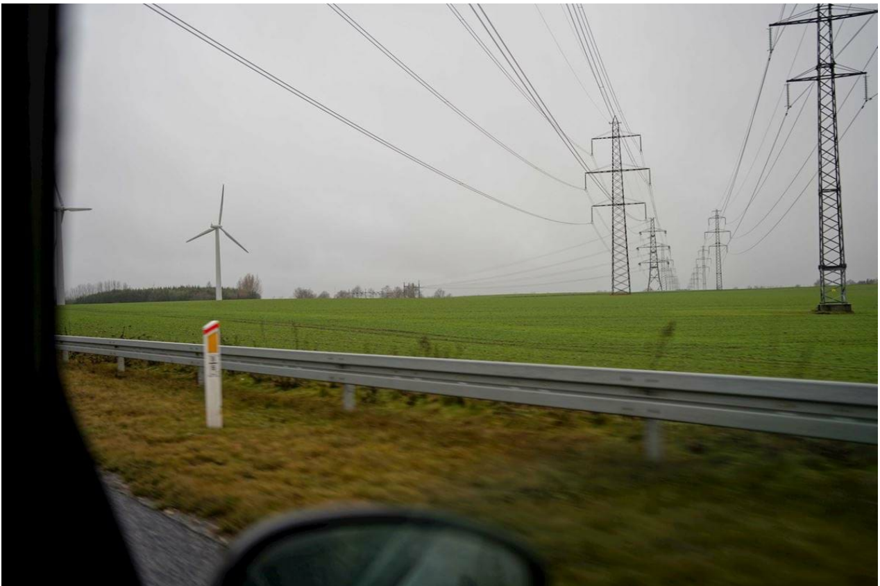
09 Eksisterende forhold set fra Fjordlandsvej
