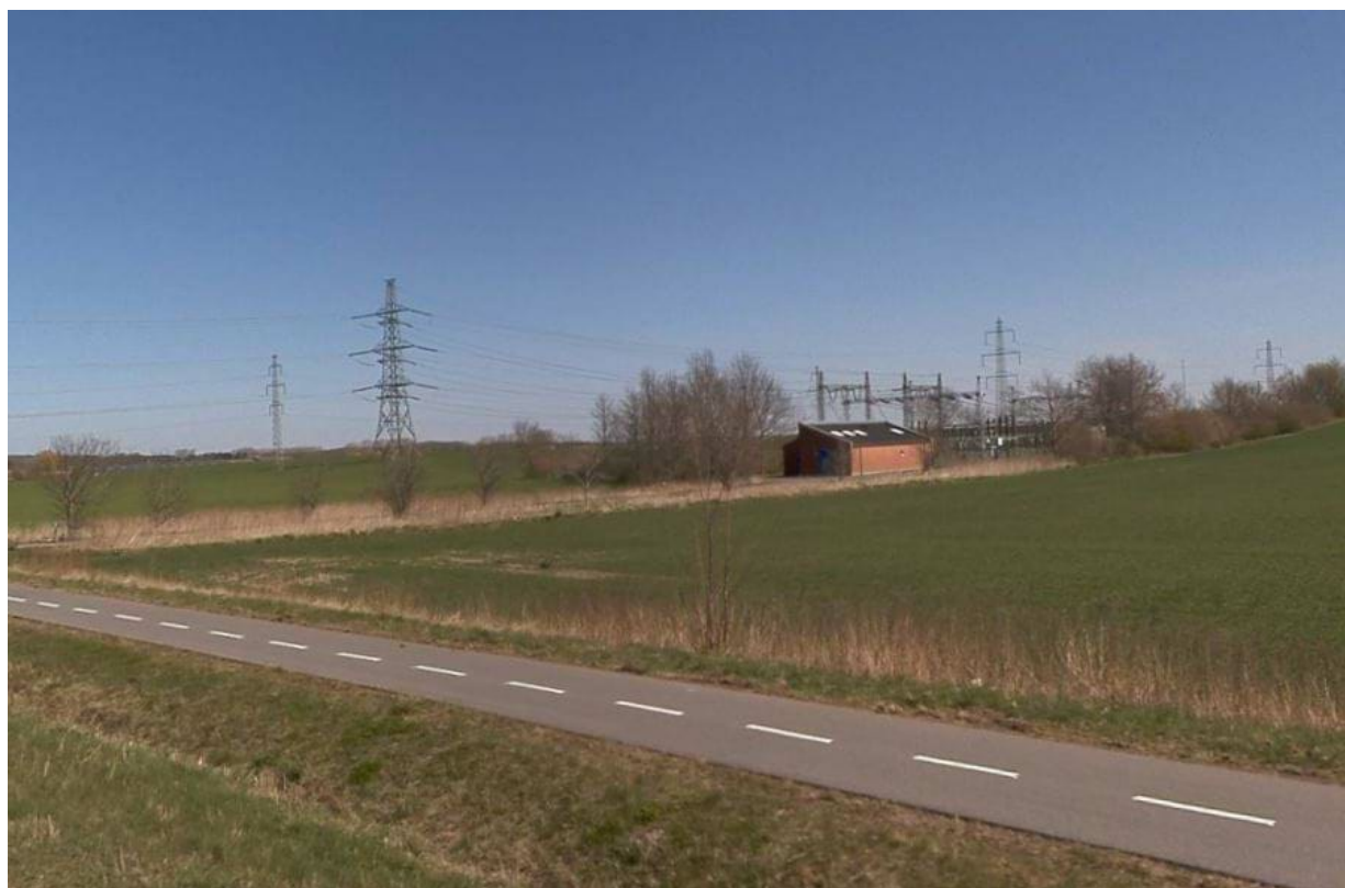
Foto 2: Viser det eksisterende højspændingsanlæg samt eksisterende forhold ved lokalplanområdet. Fotoet er taget fra sydvest fra Lyngerupvej.
