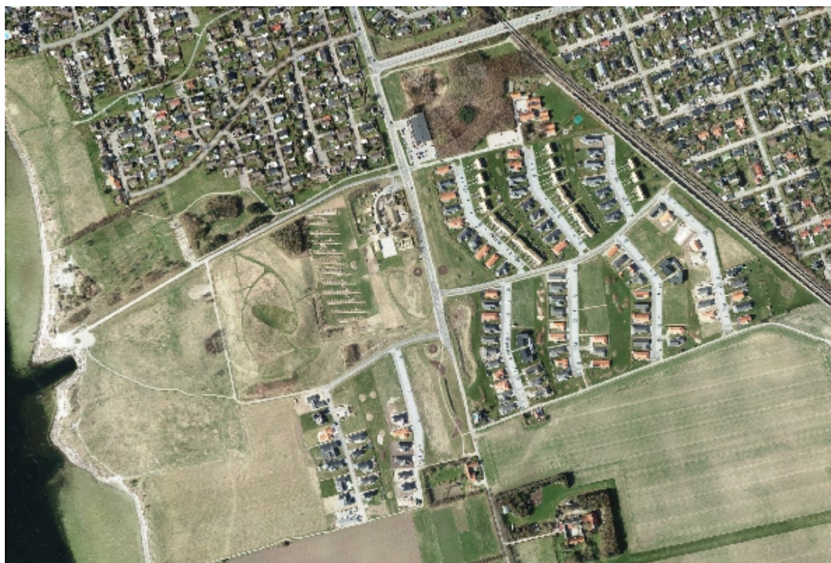
Luffoto der viser Ørnestens Vænge og Gyldenstens Vænge i foråret 2013
