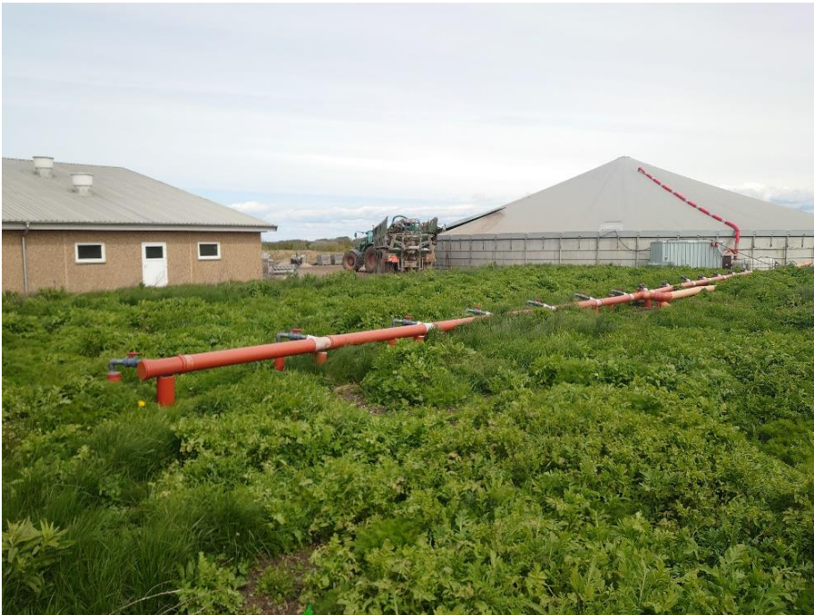
Foto af filter om vinteren/itdlig forår. Biofilteret er varm pga. metanoxiderations aktiviteten, men luften kold. Vegetation trives godt i det.
