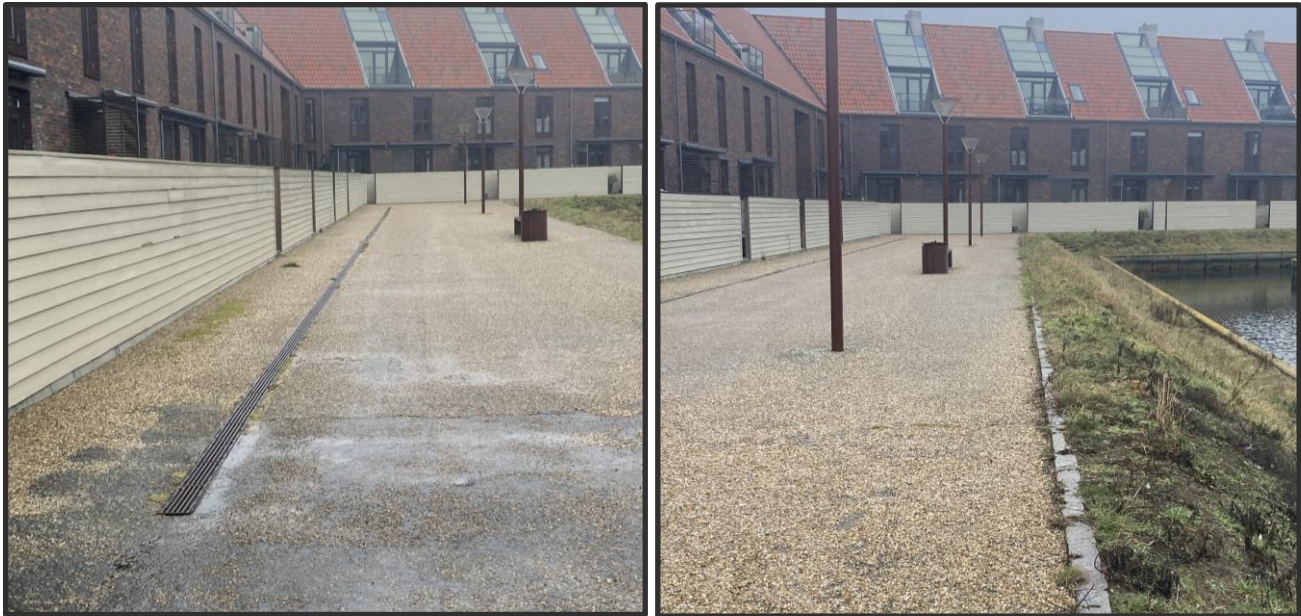
Figur 2.6: Gangareal langs Amsterdamhusene ud mod Berntsens kanal. Fotos: NIRAS, Marts 2023.
