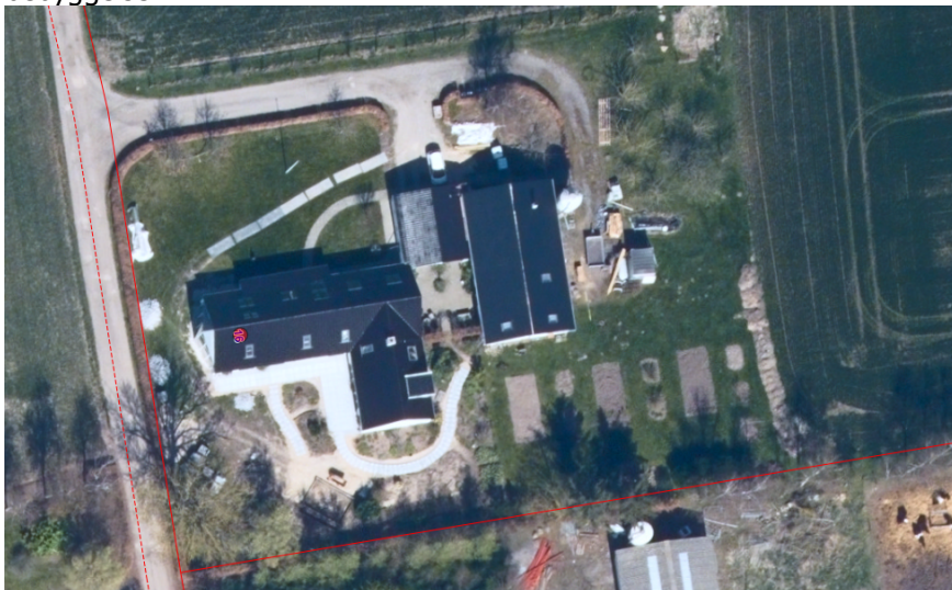
Figur 2 Luftfoto fra 2023. Fundamentet til drivhuset er sat 2,6 meter fra skel og ca. 7 meter fra den primære bebyggelse
