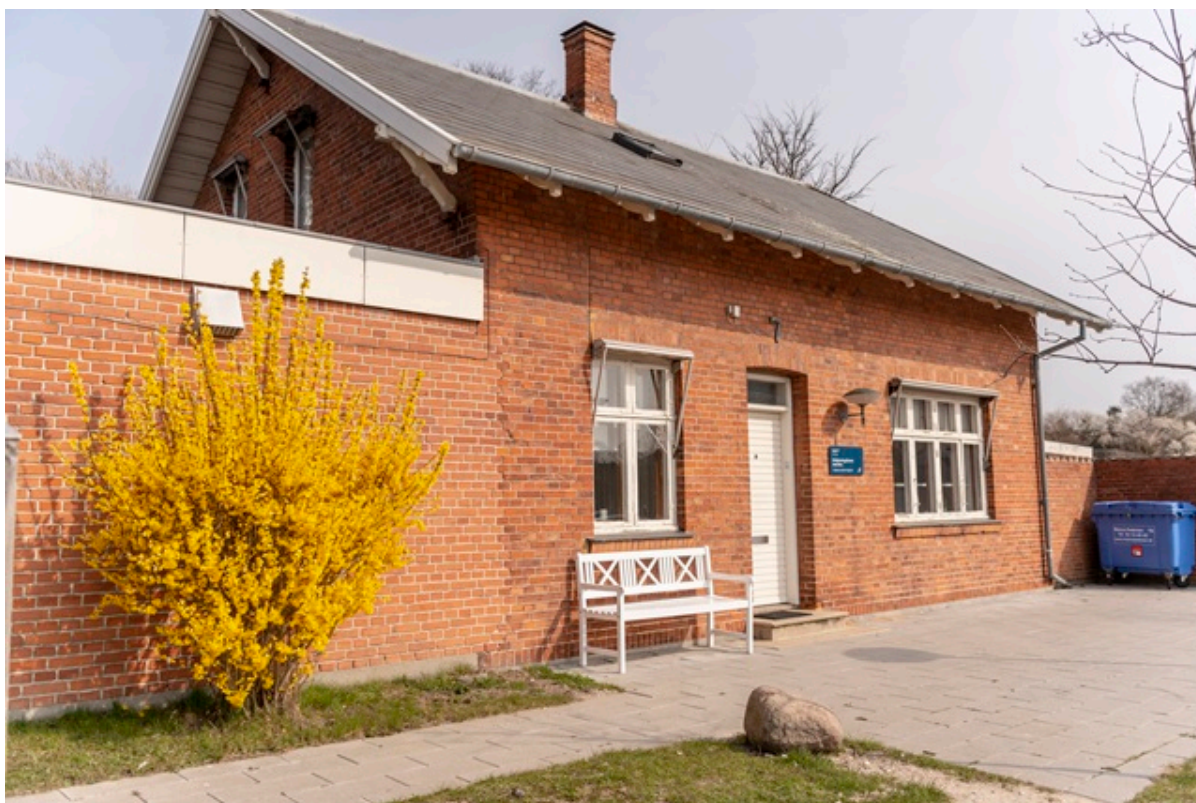
Huset på Kilde Allé 9 i Frederikssund, hvor Boligcafé for unge flytter til. Foto: Kenneth Jensen.
