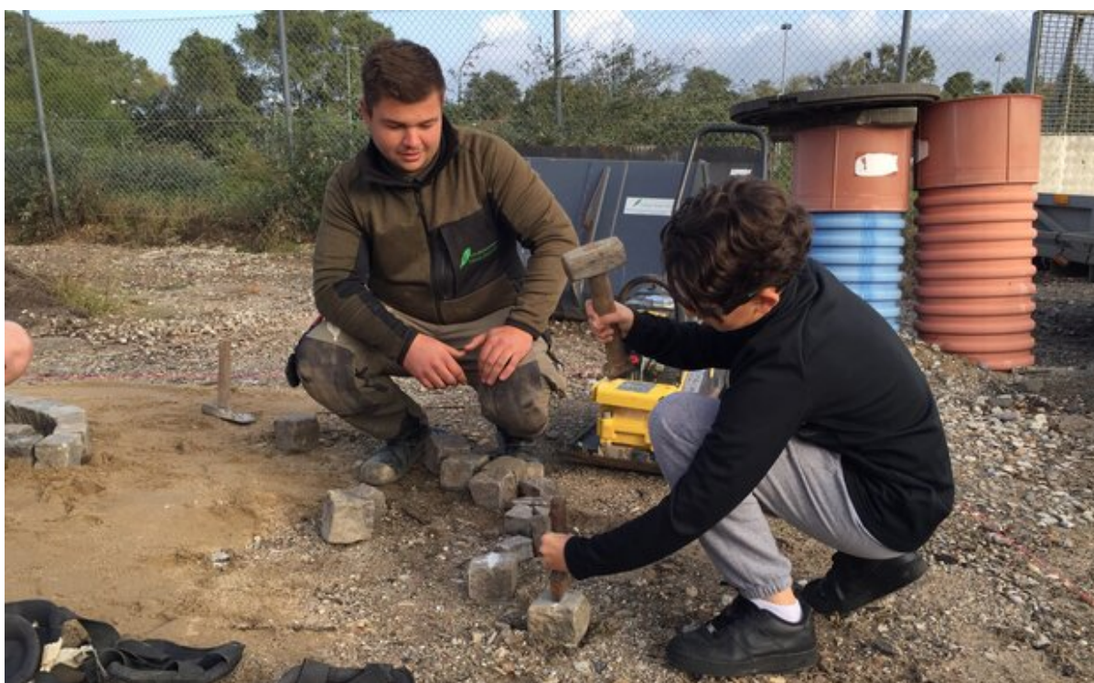
Der øves i at flække chaussésten. Foto: Frederikssund Kommune.
