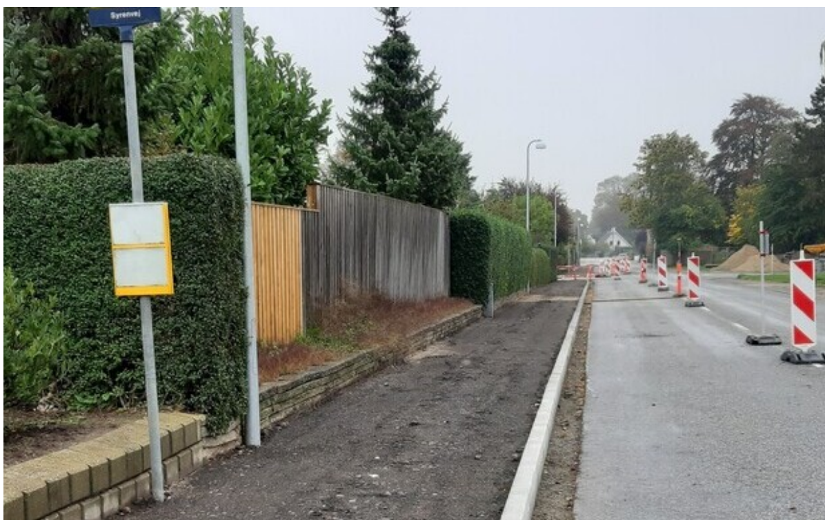
En del af strækningen på Saltsøvej i Skibby, hvor der arbejdes med anlæggelse af ny fællessti. Foto: Frederikssund Kommune.
