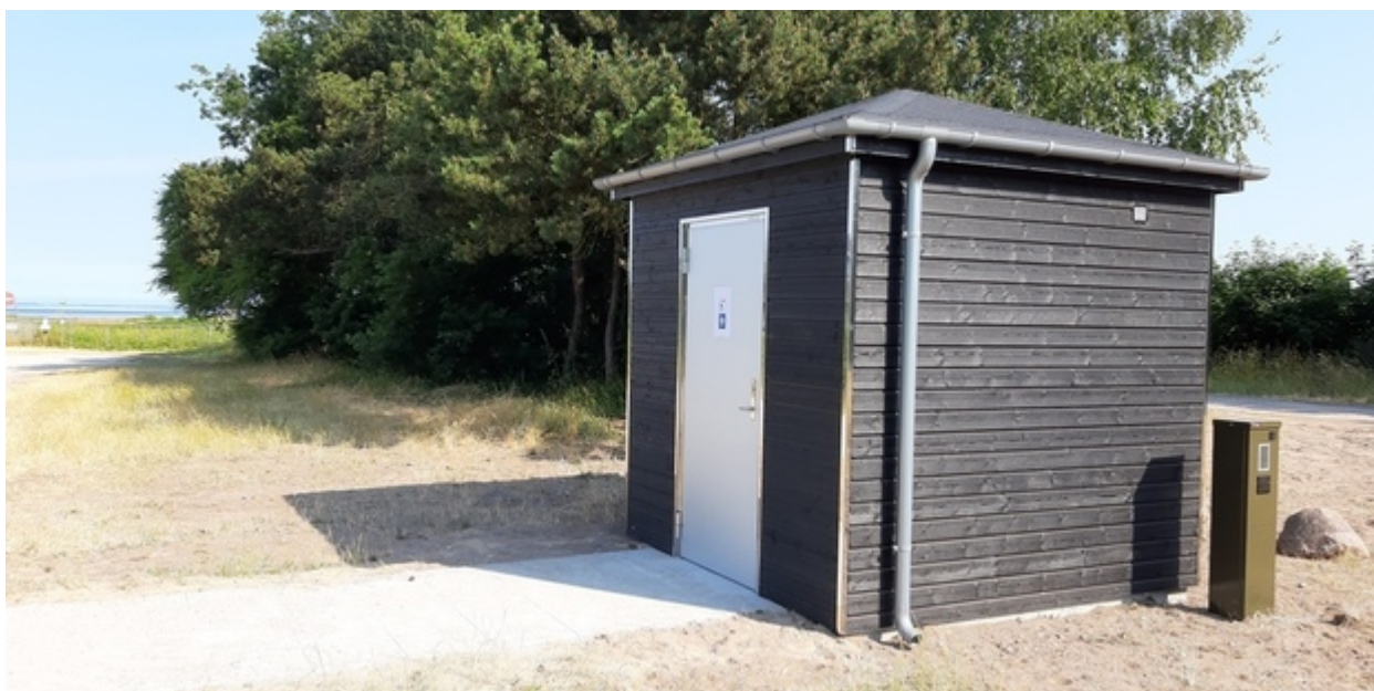
Toiletbygningen ved Dalby Huse Strand.
