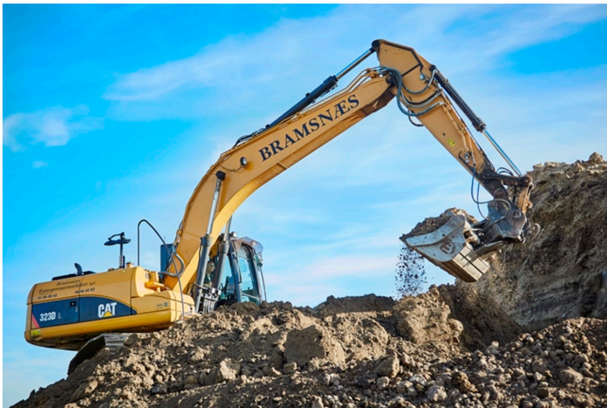
Gravemaskine graver i jorden. foto: Frederikssund Kommune.
