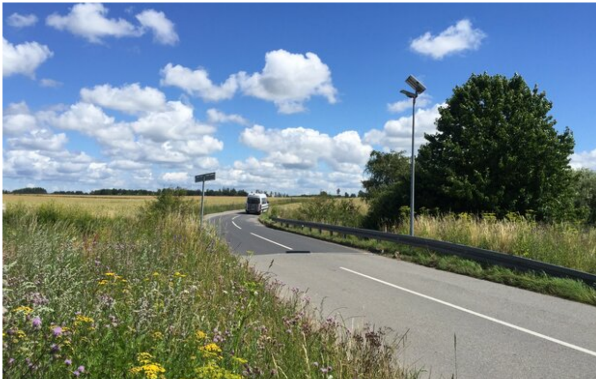
Oppe-Sundbyvej bliver lukket fra den 15. juli. Foto: Frederikssund Kommune.
