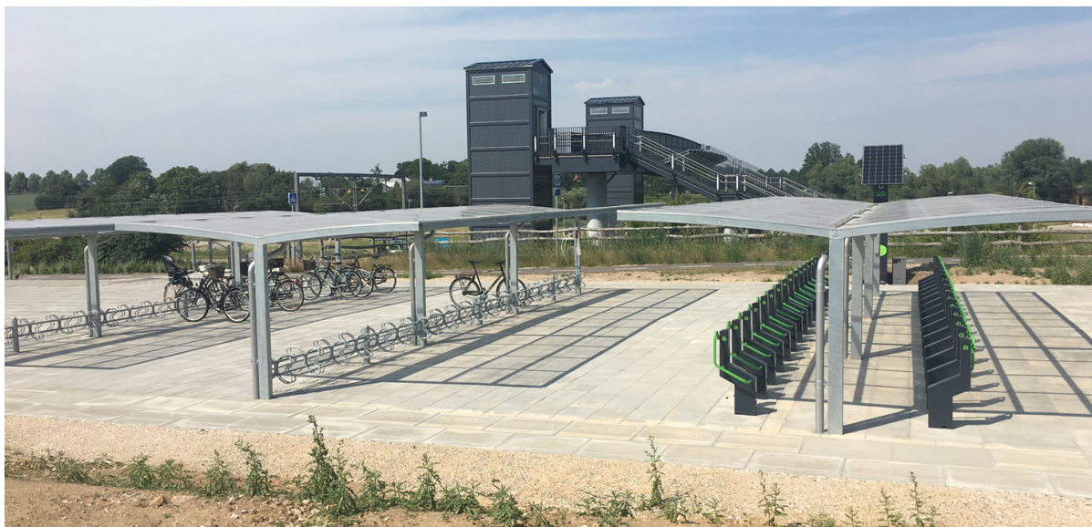
Ny overdækket cykelparkering ved Vinge Station. Foto: Frederikssund Kommune.
