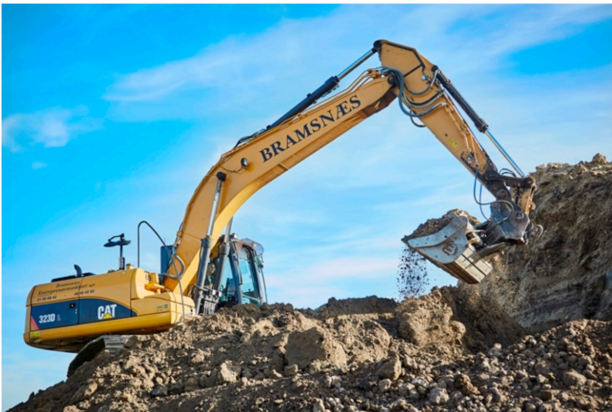
Gravemaskine graver i jorden. foto: Frederikssund Kommune.
