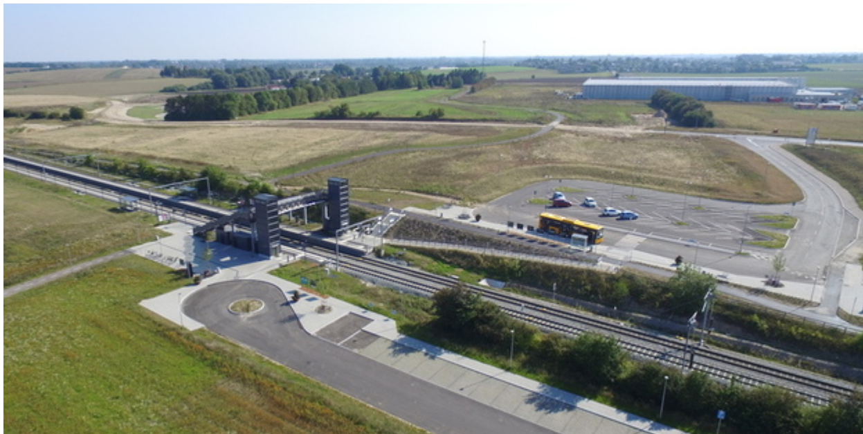
Vinge Station med marker, fællesmagasinet og Snostrup/St. Rørbæk i baggrunden.
