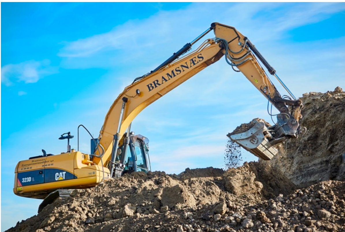
Gravemaskine graver i jorden. foto: Frederikssund Kommune.
