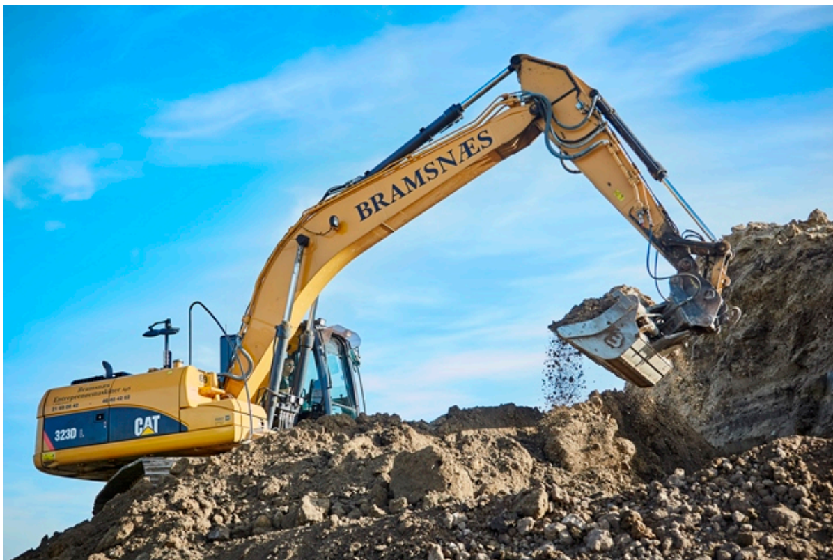
Gravemaskine graver i jorden. foto: Frederikssund Kommune.
