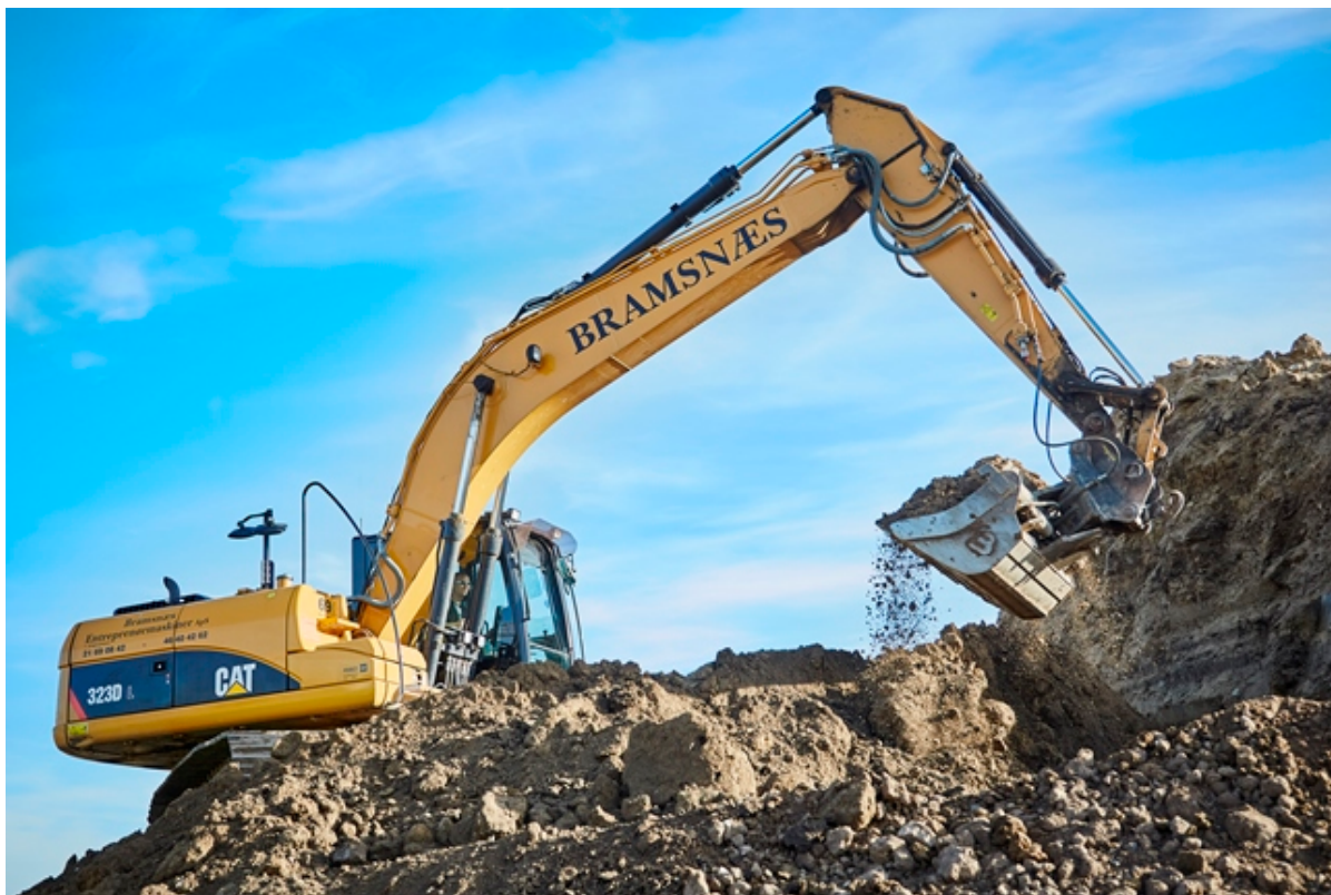
Gravemaskine graver i jorden. foto: Frederikssund Kommune.
