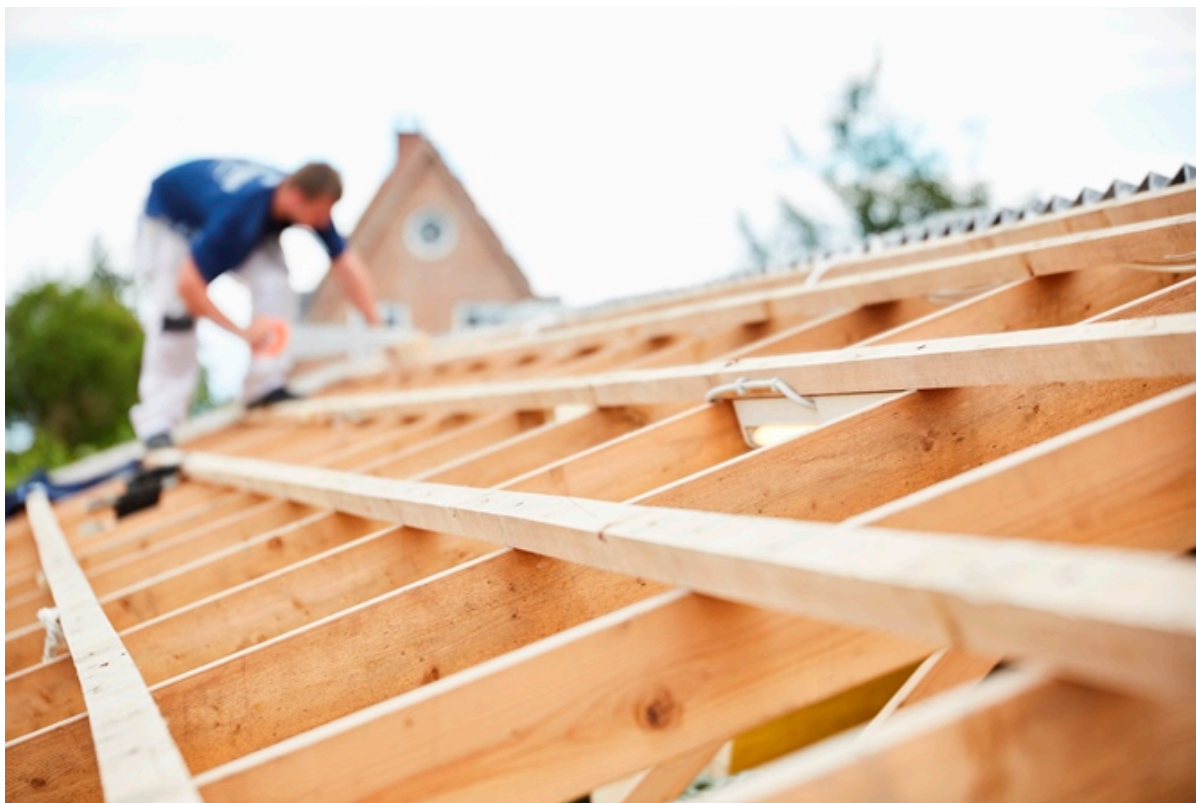
En tømrer arbejder på et tag. Foto: Frederikssund Kommune.
