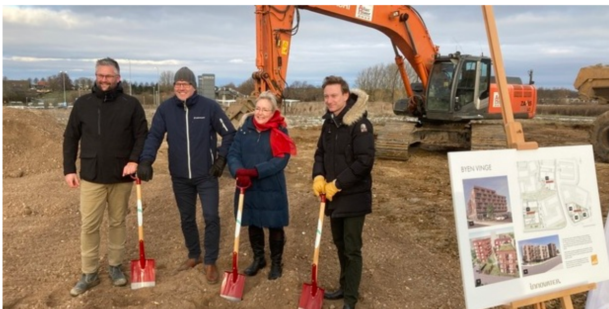
Entreprenører, borgmester og ejendomsudvikler tager første spadestik til et nyt byggeri i Vinge. foto: Frederikssund Kommune.
