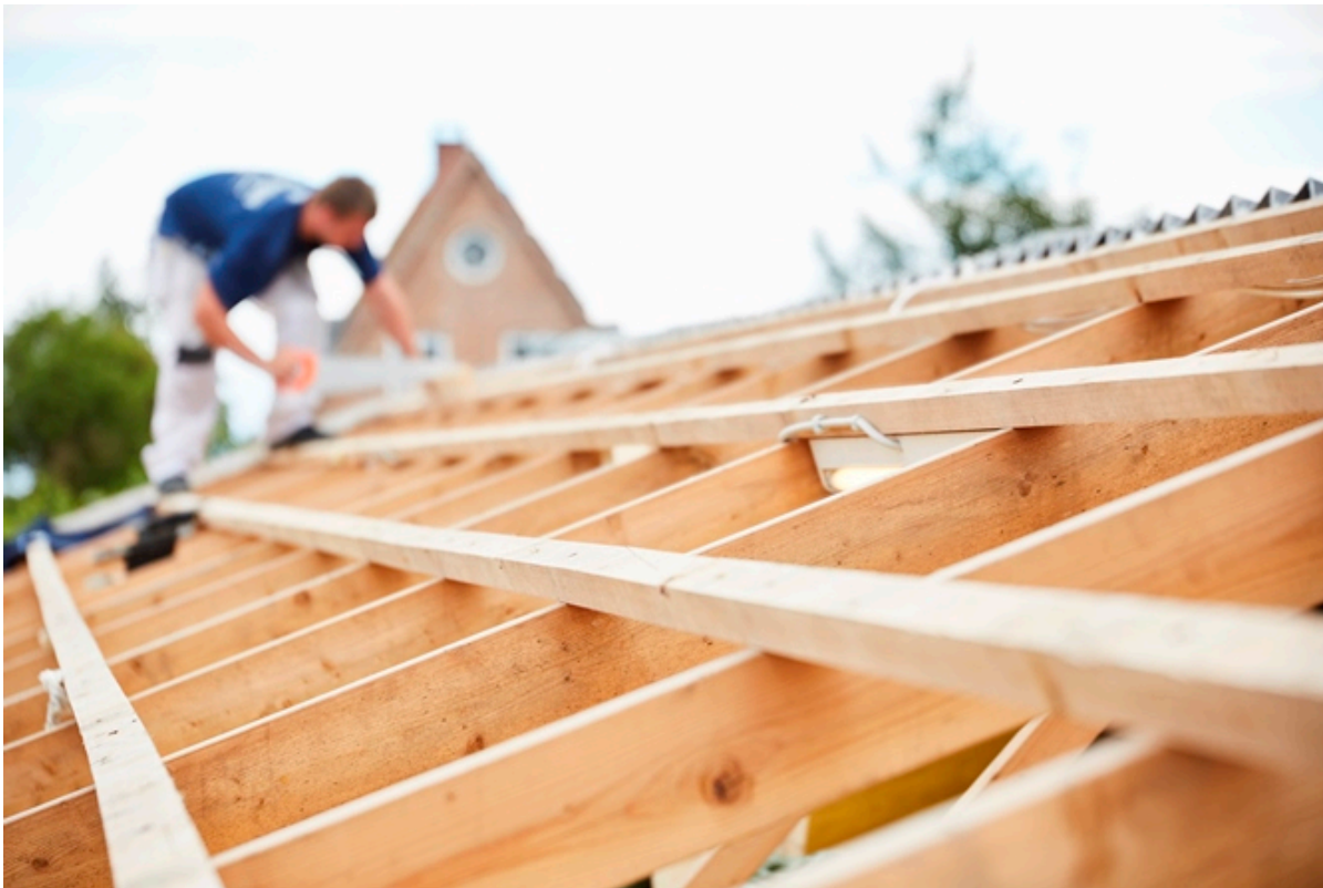
Tømrer arbejder på et tag. Foto: Frederikssund Kommune.
