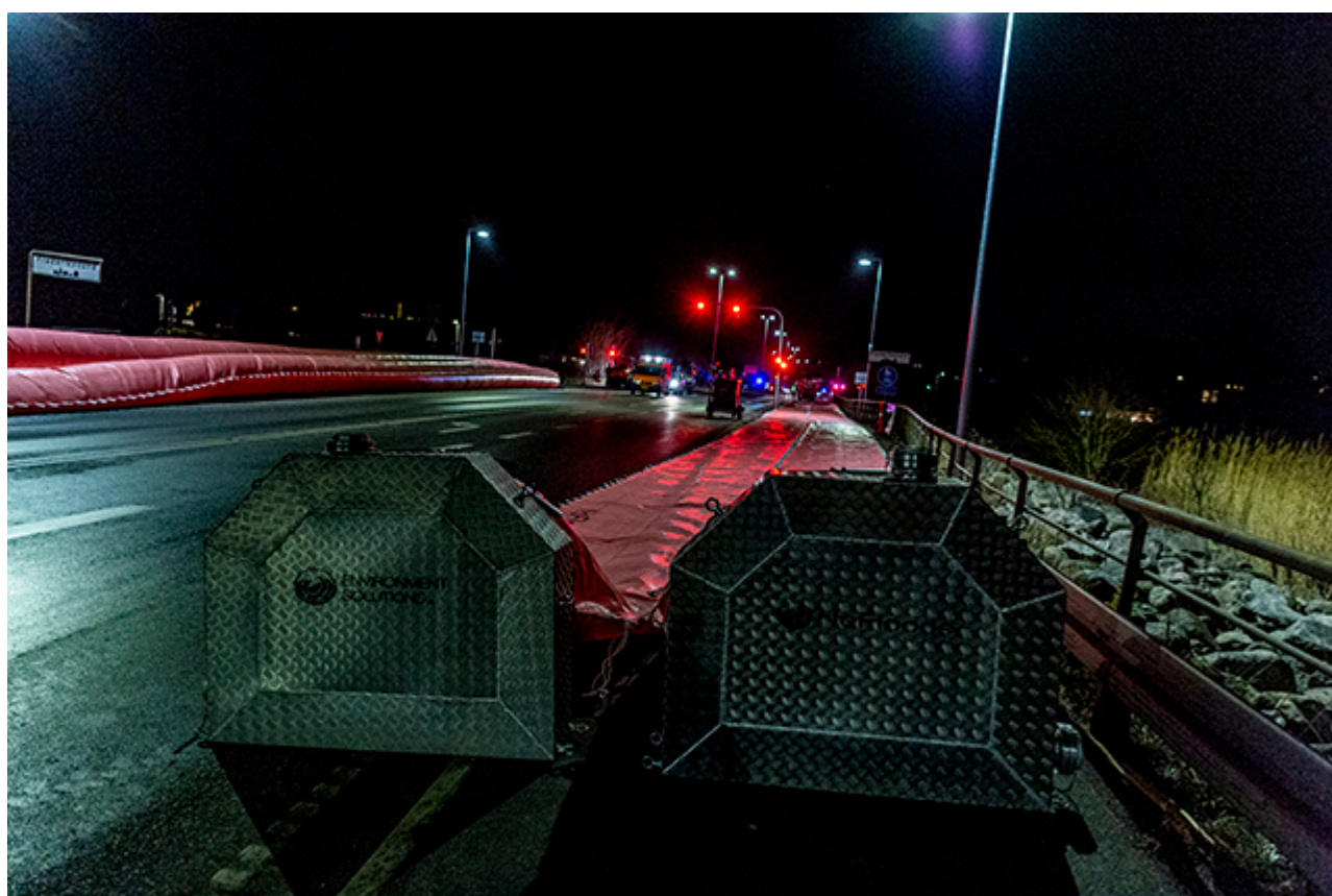
Watertubes er klar til fyldning med vand.
