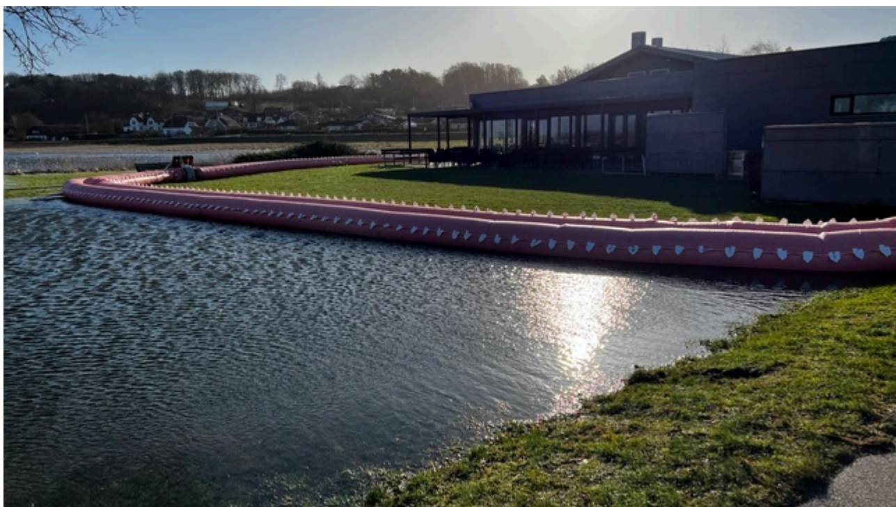
Watertuben ved Kignæshallen har holdt vandet væk fra hallen.
