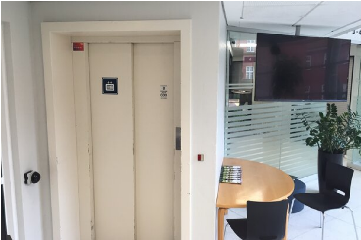
Rådhusets elevator i forhallen. Foto: Frederikssund Kommune.
