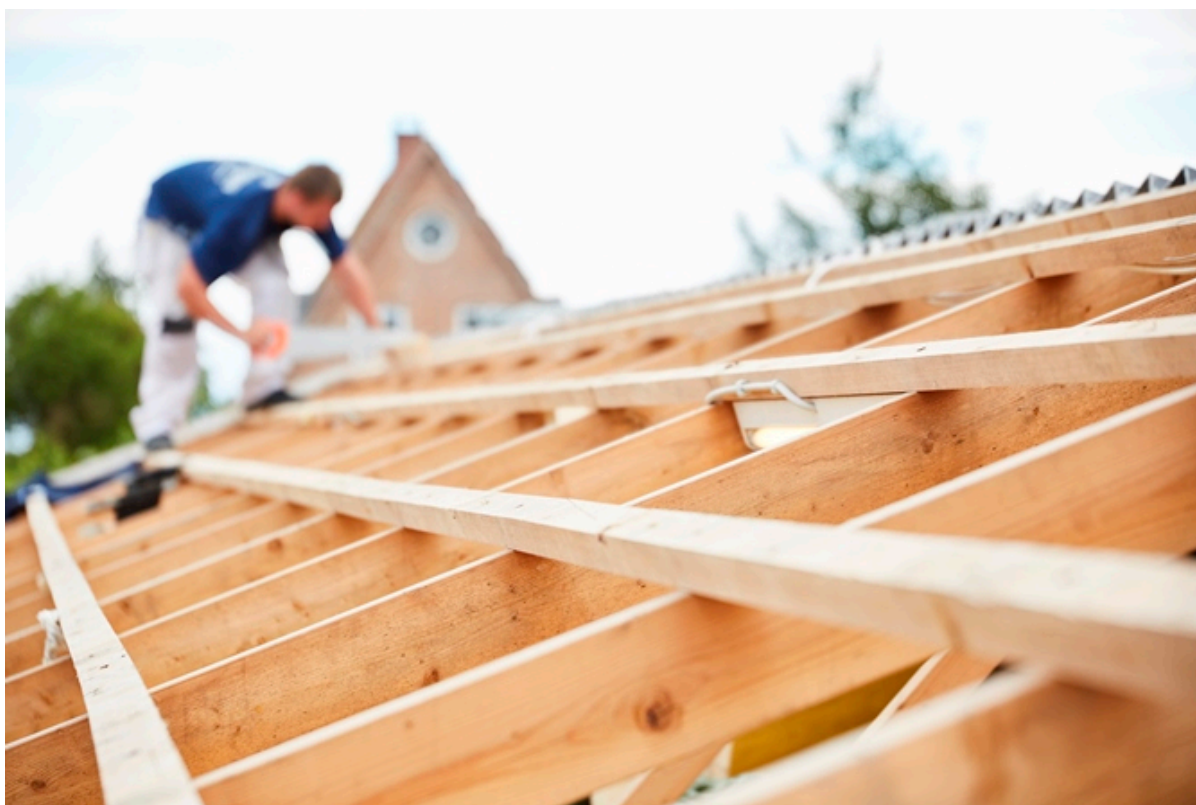
En tømrer arbejder på et hustag. Foto: Frederikssund Kommune.
