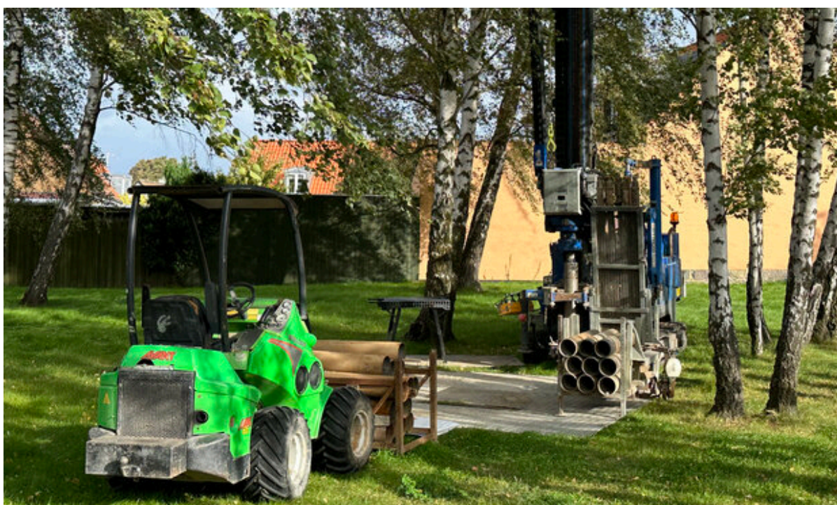
Maskiner til geotekniske undersøgelser nær Toldboden i Frederikssund. Foto: DJ Boringer.
