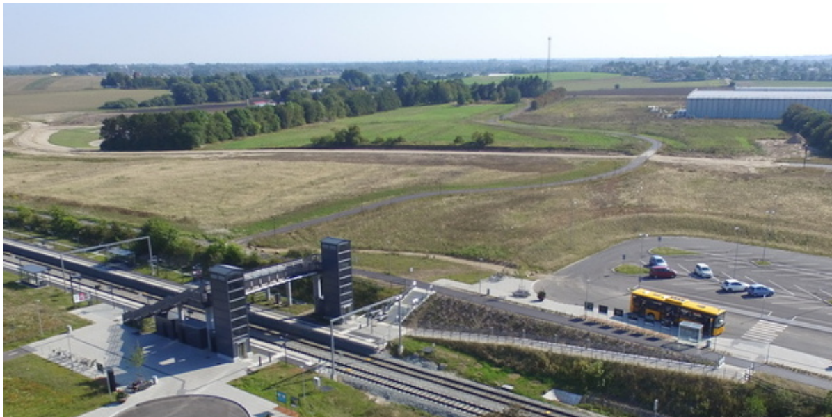
Vinge Station og p-plads. Foto: Frederikssund Kommune.
