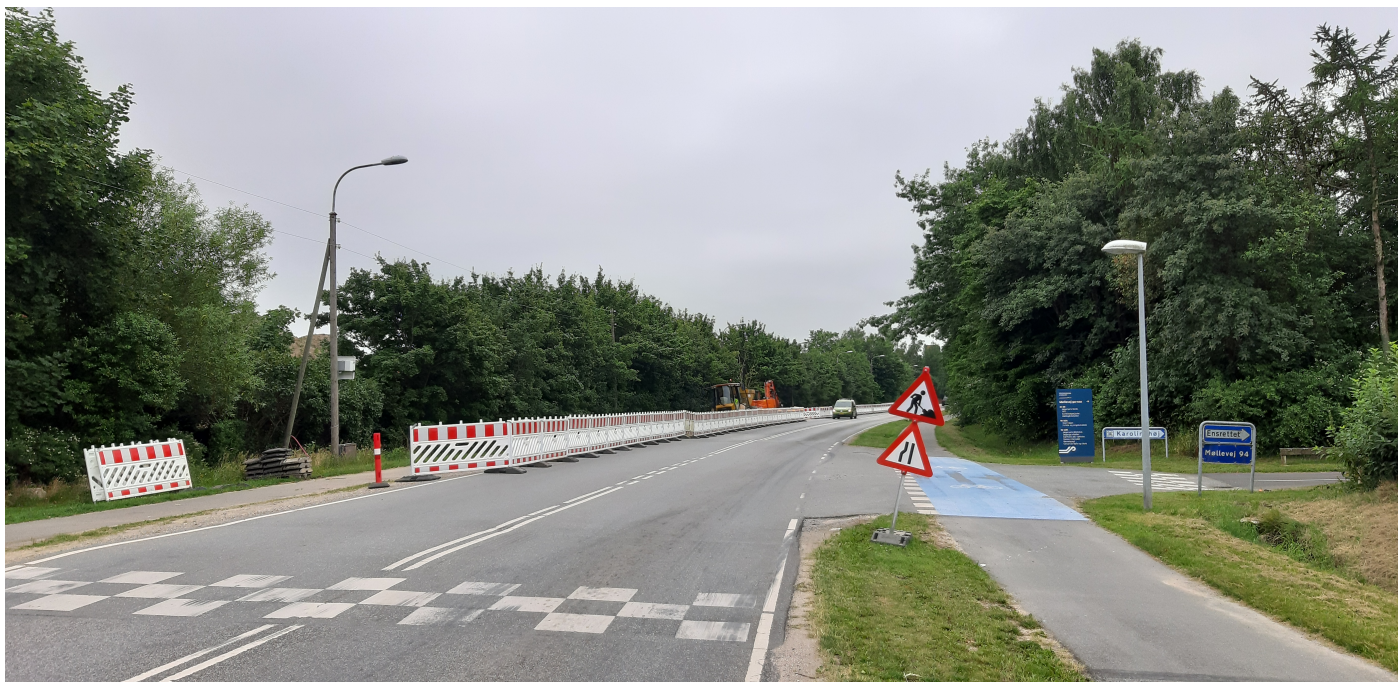
Forberedelse af vejarbejde på Møllevej i Jægerspris.
