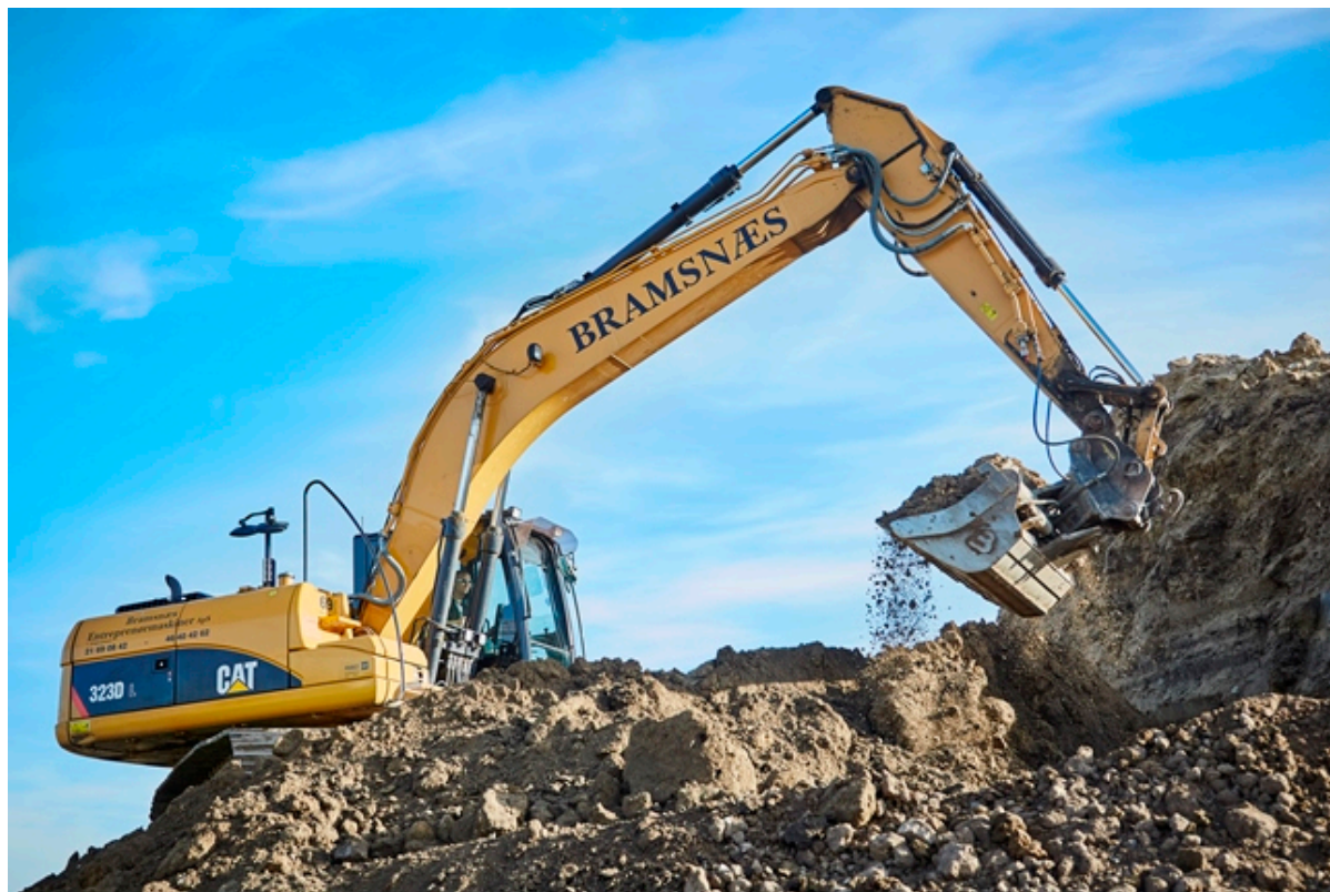
Gravemaskine graver i jorden. foto: Frederikssund Kommune.
