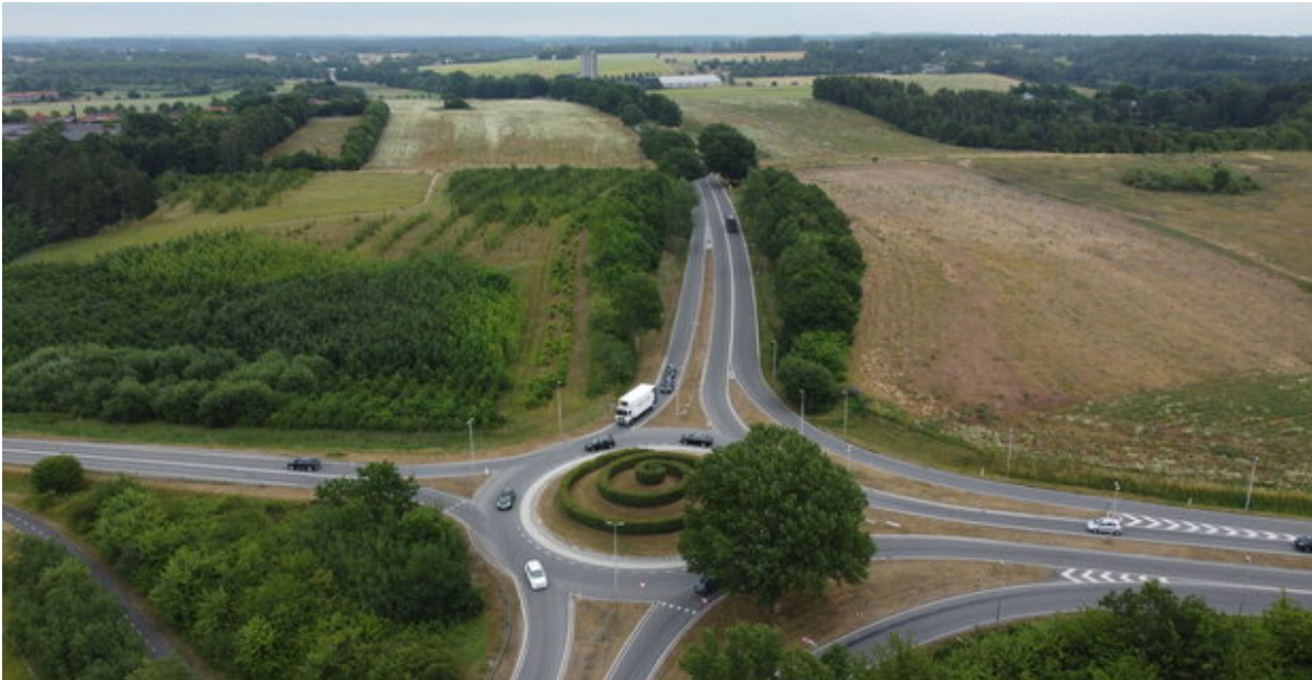
Hørup Skovvej og rundkørslen Roskildevej/Hørup Skovvej. Foto: Frederikssund Kommune.
