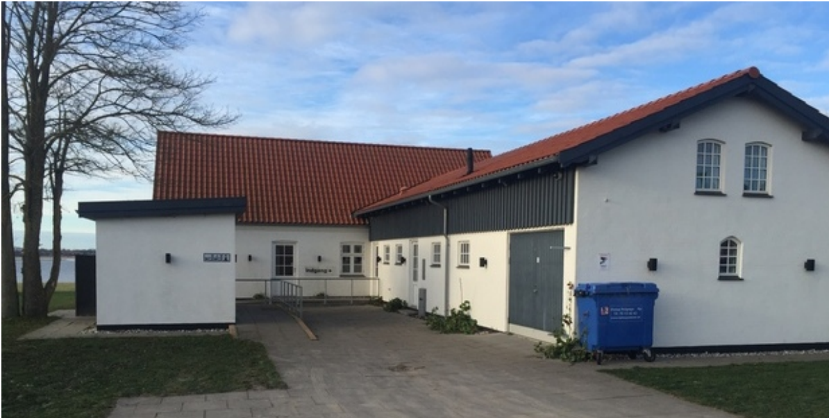
Østersvej 4. Foto: Frederikssund Kommune.
