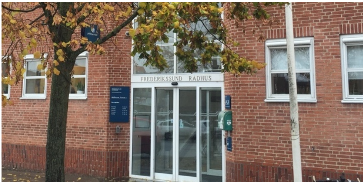
Indgangspartiet på Frederikssund Rådhus. Foto: Frederikssund Kommune.
