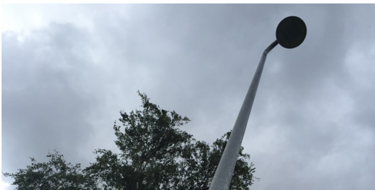
Slukket gadelampe. Foto: Frederikssund Kommune.
