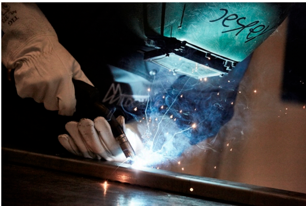
Smed svejser et stykke stål. Foto: Frederikssund Kommune.
