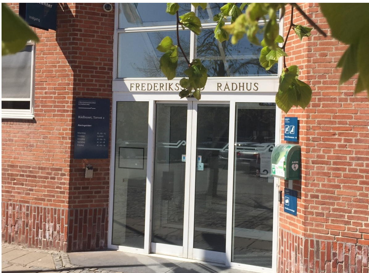
Indgangen til Frederikssund Rådhus og borgercentret. Foto: Frederikssund Kommune.
