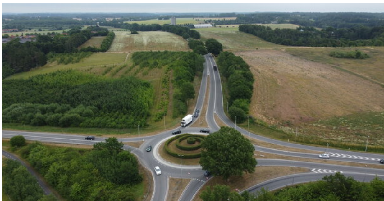
Hørup Skovvej og rundkørslen Roskildevej/Hørup Skovvej.
