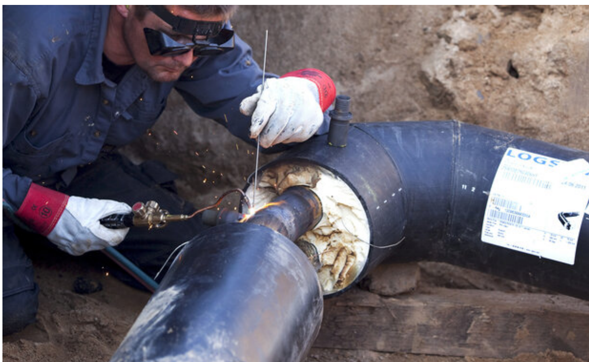
En person arbejder ved et fjernvarmerør. Foto: Dansk Fjernvarme.
