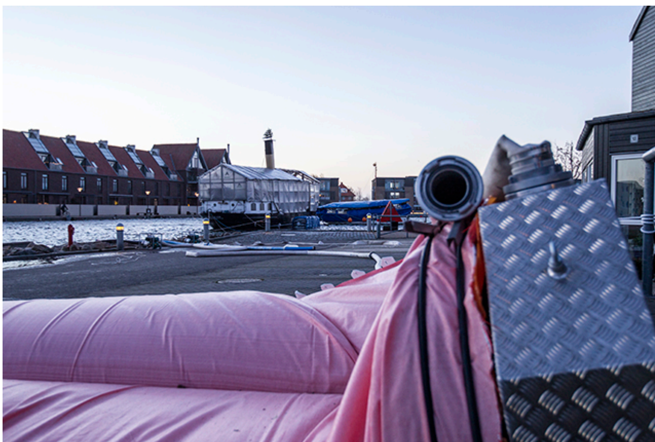
Arkivfoto fra udlægning af watertubes på Nordkajen i Frederikssund.
