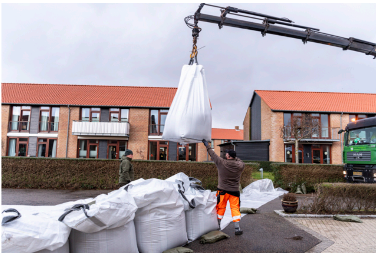
Der bygges dige med big bags.
