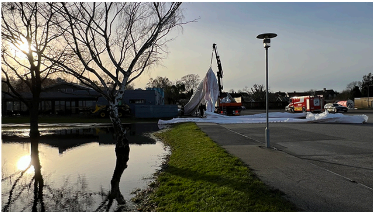
Watertube "trækkes på land" ved Kignæshallen i Jægerspris, for at blive rettet ud og rullet op.
