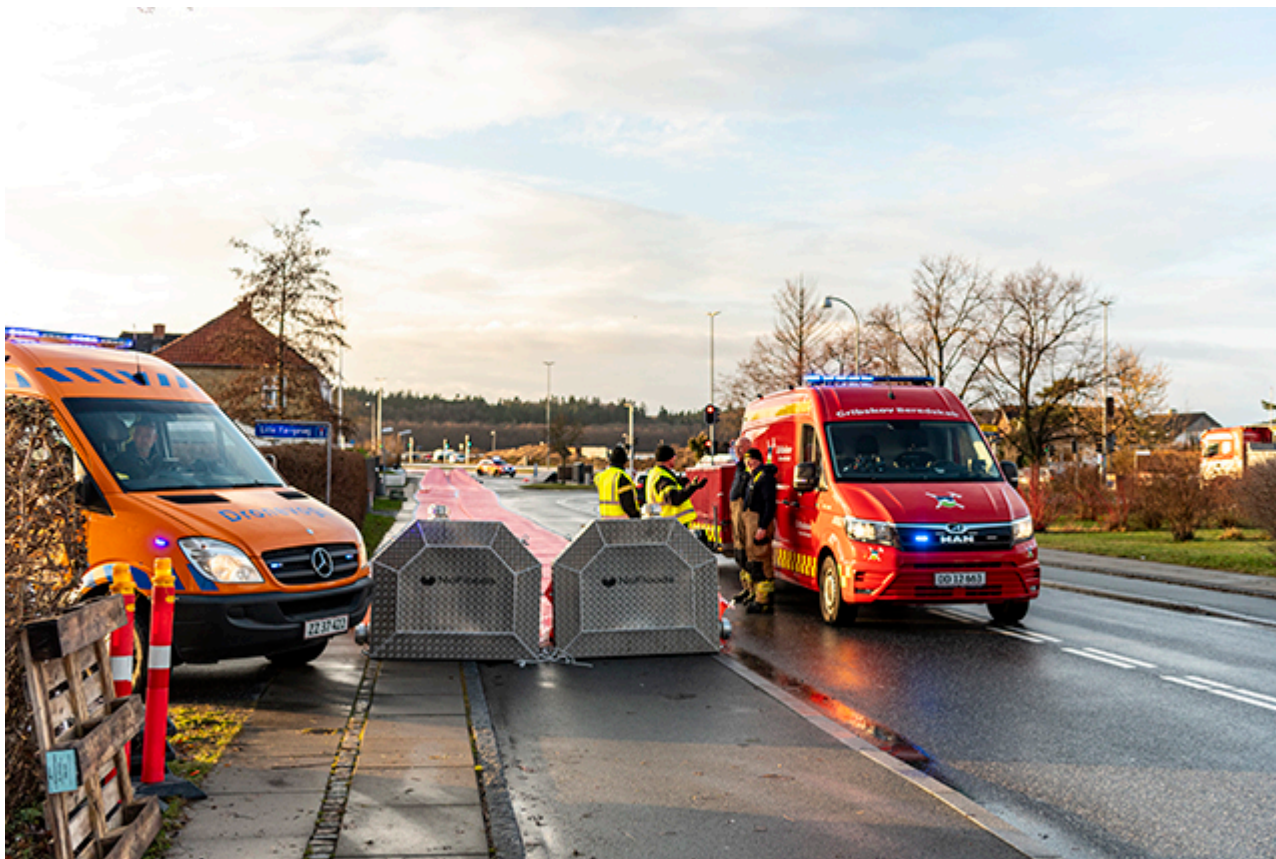
Watertube på Færgevej i Frederikssund ved udlægningen onsdag.
