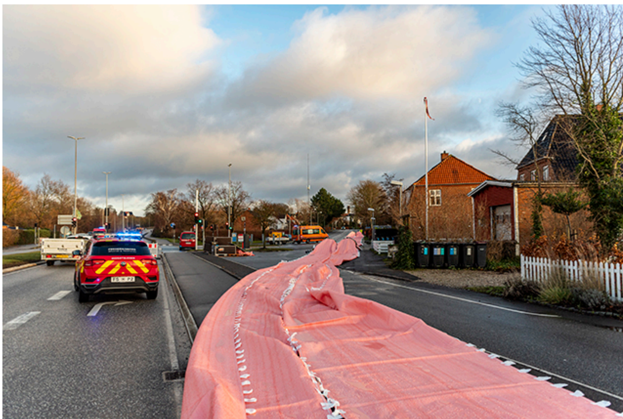
Arbejdet med udlæggelse af watertubes er i fuld gang i de sidste timer med dagslys.
