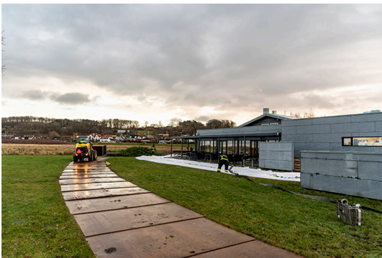
Arbejdet med udlæggelse af watertubes er i gang ved Kignæshallen.
