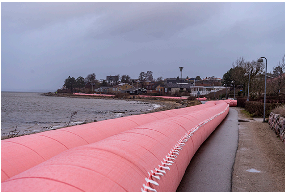
Watertubes langs Strandvej i Frederikssund ved stromfloden Malik i januar 2022. Foto: Kenneth
