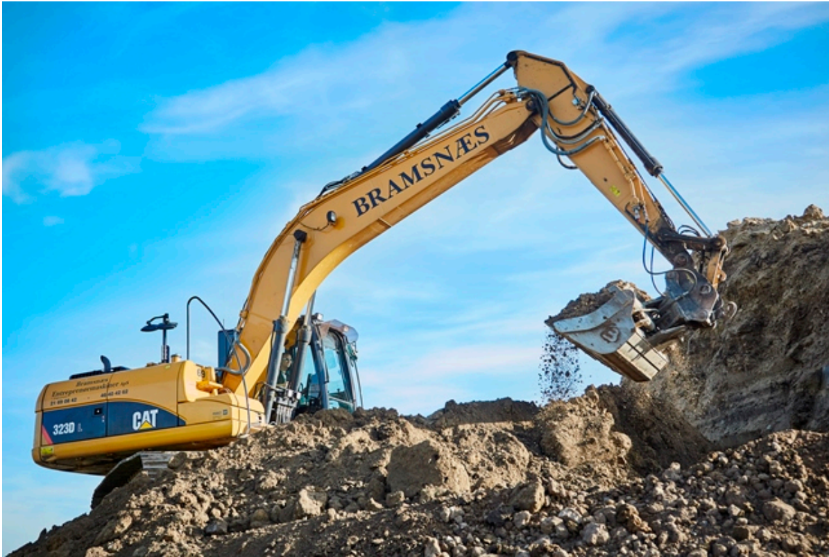
Gravemaskine flytter jord. Foto: Frederikssund Kommune.
