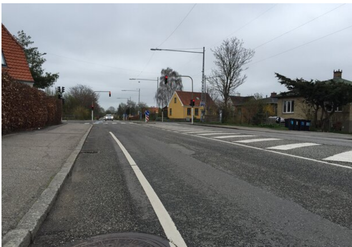
Københavnsvej i Slangerup. Foto: Frederikssund Kommune.
