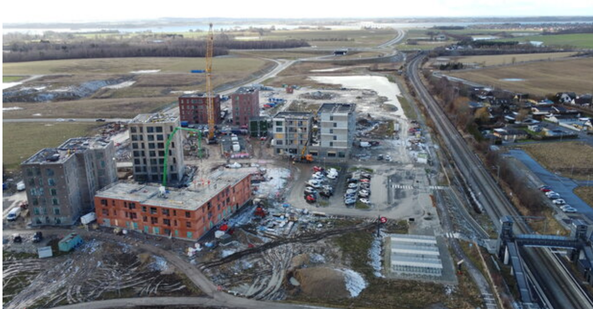
Byggepladsen ved Vinge Station set i retning mod vest. Foto: Frederikssund Kommune.
