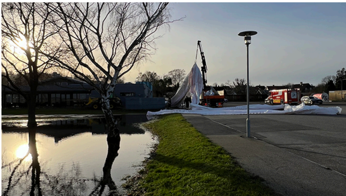
Watertubes "trækkes på land" for at blive rettet ud og rullet op. Foto: Kenneth Jensen, Frederikssund Kommune.
