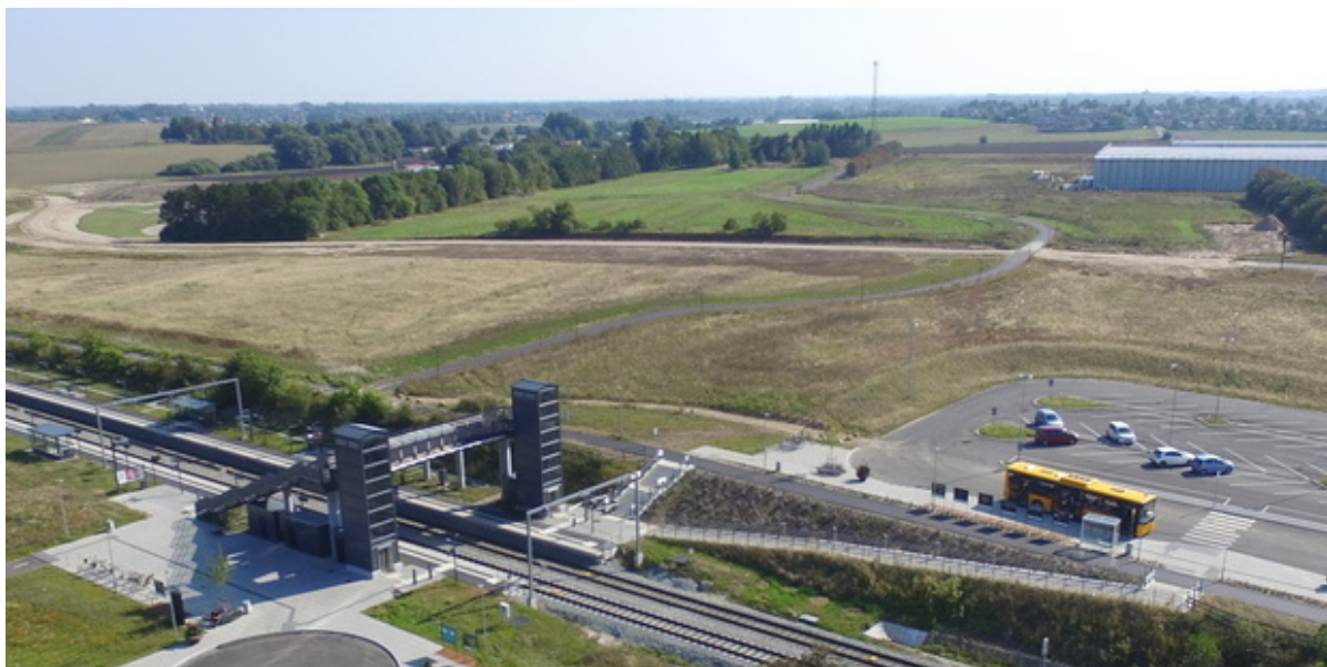
Vinge Station og p-plads. Foto: Frederikssund Kommune.
