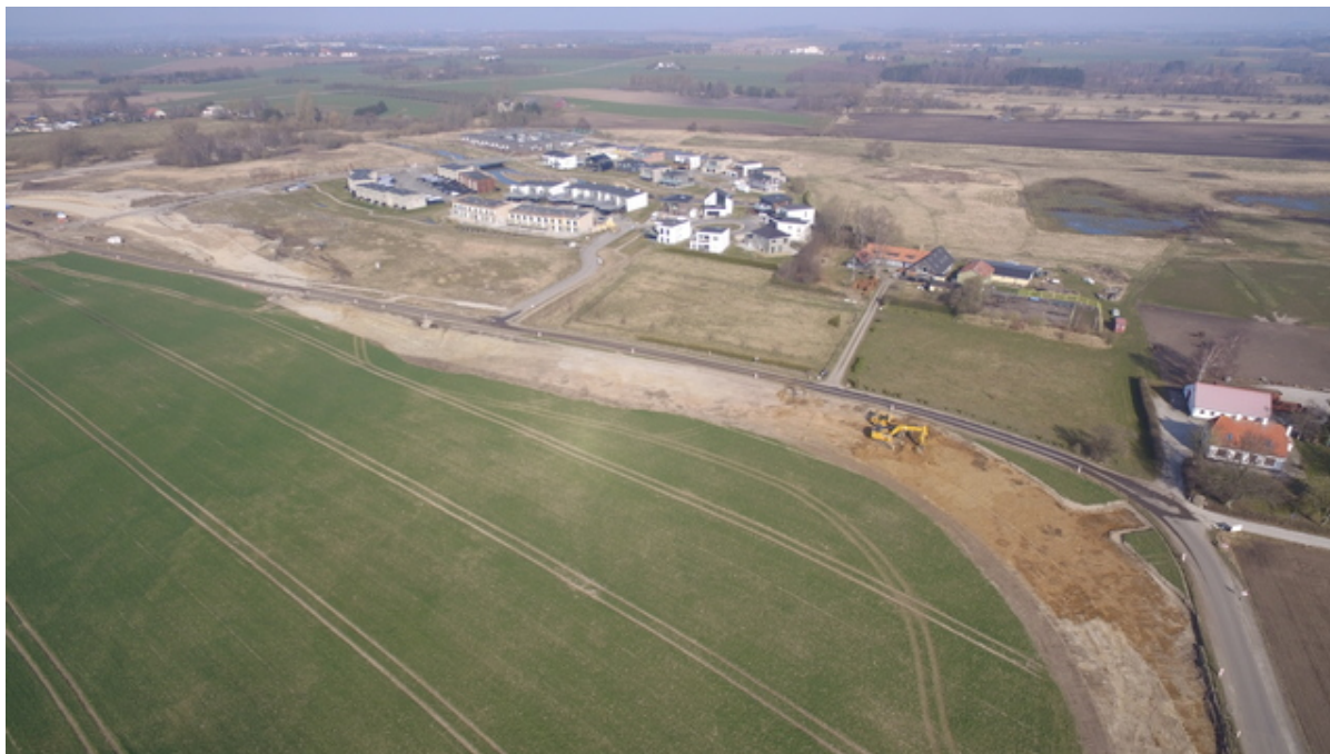
Vejarbejde på Dalvejen. Foto: Frederikssund Kommune.
