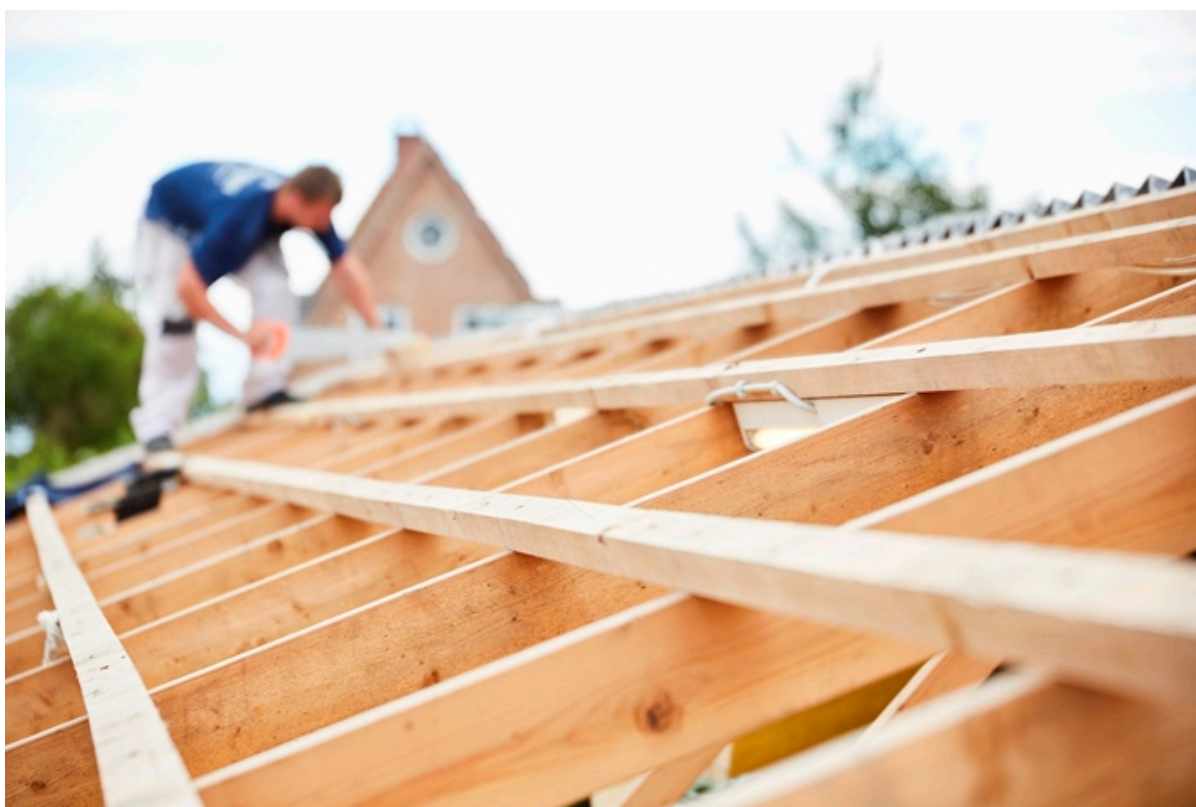
Håndværker arbejder på et tag. Foto: Frederikssund Kommune.
