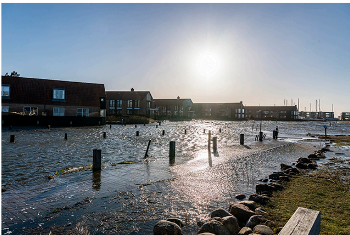
Højvande ved Skillebakke Havn. Foto: Frederikssund Kommune, Kenneth Jensen.
